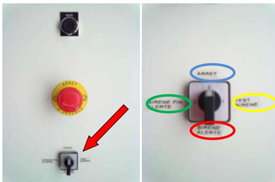
Il faut d'abord sélectionner via le commutateur puis appuyer sur le bouton « sirène ».
